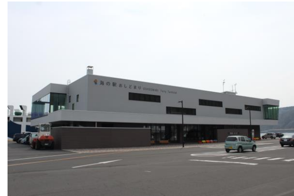
海の駅おしどまり 全景 (陸側)
