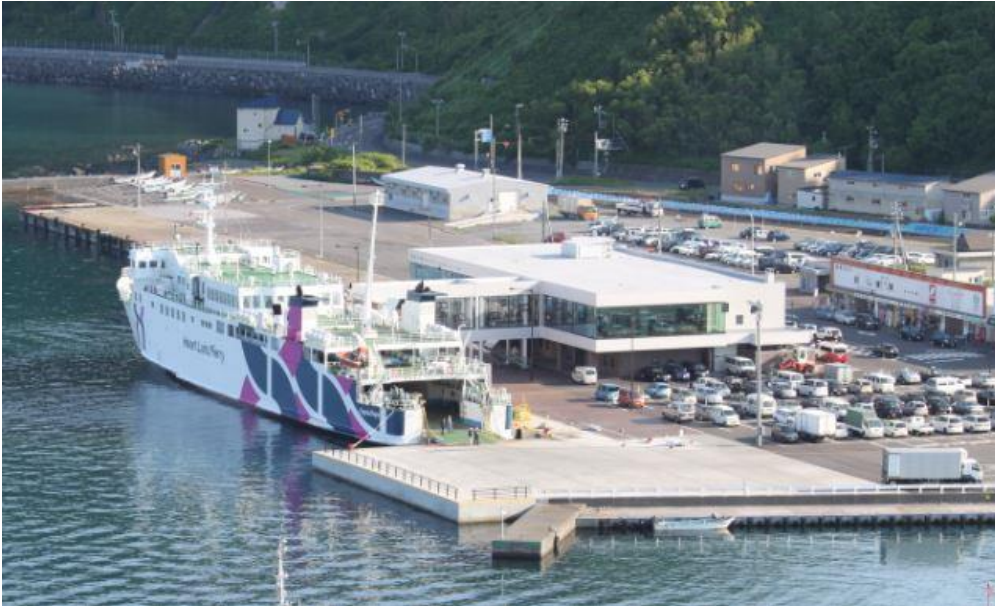
海の駅おしどまり 全景
