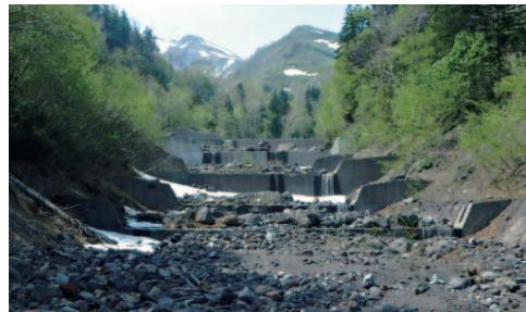
写真：アフトロマナイ川の床固工
