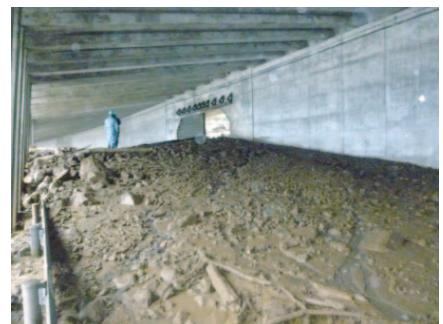
写真：湾内覆道の流出土砂（H28）
