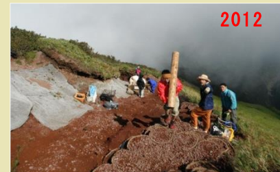
当協議会では、登山道がこれ以上崩壊することを防ぐため、土留めを設置するなど、毎年登山道の補修作業を行っています。
