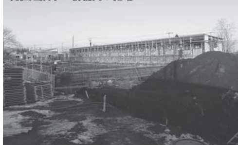
現在建設中の新朝日ふ化場
