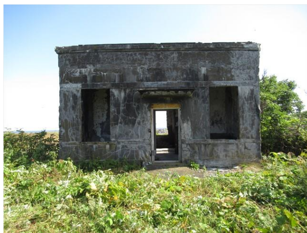
石崎に残る海底電線接続所(陸揚庫)
