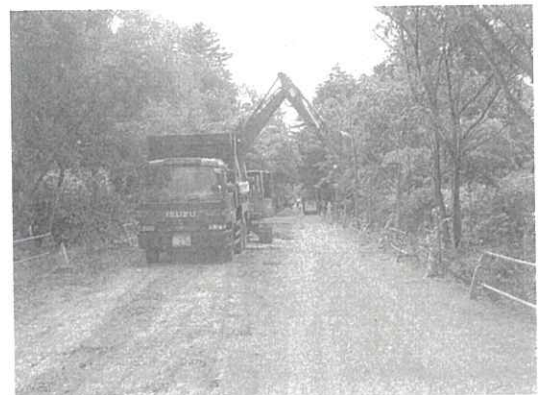
甘露水線改良工事現況
