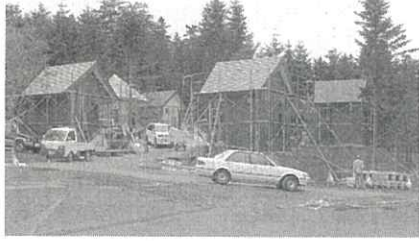
建設中のバンガロー6棟
