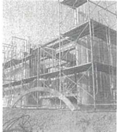
新築される給食センター
