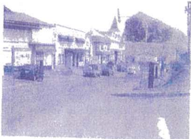
←鷺泊地区の道道拡幅工事 早期着工へ
