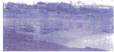
→近年砂による侵食が著しく、付近の人家等への被害が懸念される大磯漁港。
