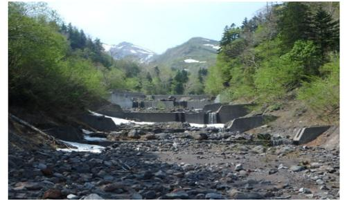
写真：アフトロマナイ川の床固工
